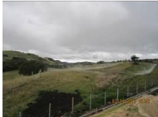
Fotografía 7-15 Nebulización de las aguas residuales industriales tratadas
