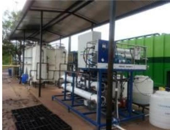
**Fotografía 7-5 Equipo de Ultrafiltración**
